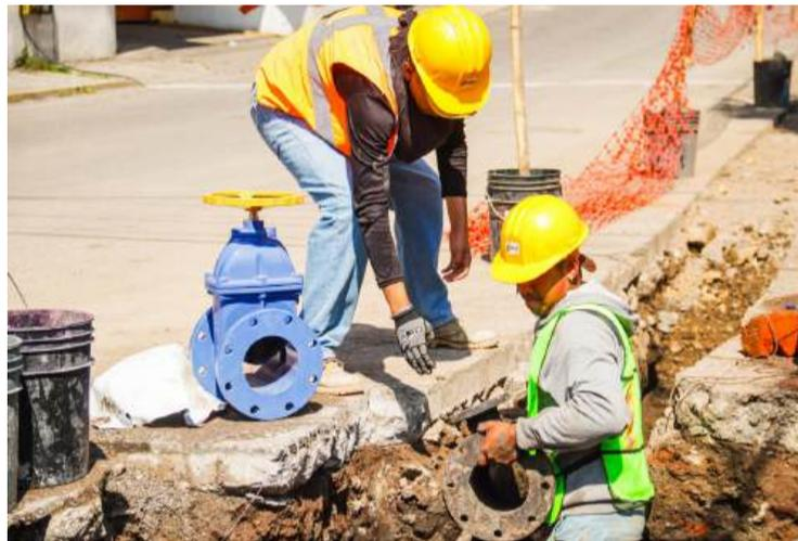
domiciliarias de 13 mm, la reparación de 43 tuberías existentes y la reparación de 311.5 m<sup>2</sup> de pavimento con concreto hidráulico premezclado.
