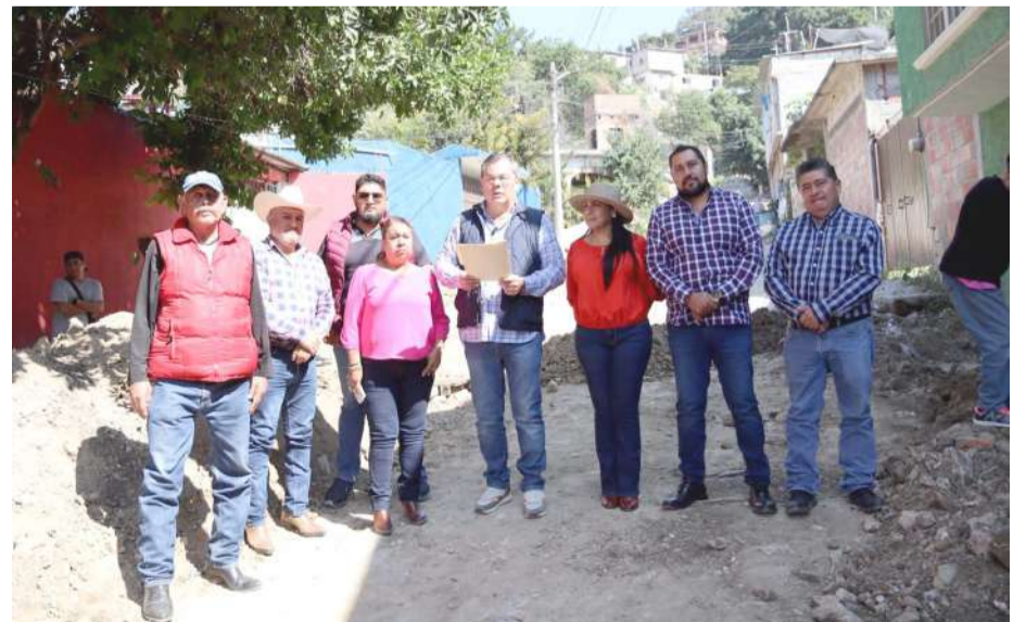
EL ALCALDE RAFAEL Reyes e integrantes del Ayuntamiento de Jiutepec realizaron una supervisión a la construcción de la red de agua potable y pavimento con concreto hidráulico en la calle 20 de noviembre de la colonia Cerro de la Corona.
